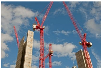
Gewohnter Anblick in der Londoner Innenstadt: WOLFFKRAN Wipper auf einer Baustelle im Stadtteil Broadgate.
